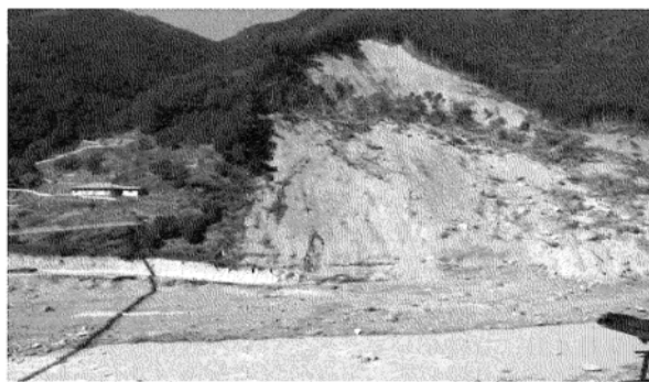
写真3 深層崩壊ともいうべき山腹崩壊
