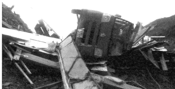
写真4 格納庫ごと転落した消防車
