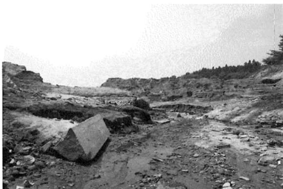
写真-1 ダム決壊正面
