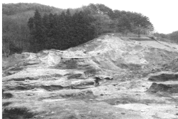
写真-4 ダム右岸側
