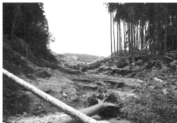
写真-5 ダム直下の河道状況
