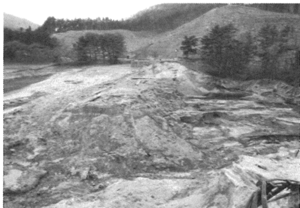
写真-3 ダム左岸側
