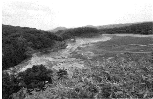
写真-2 ダム決壊上空
