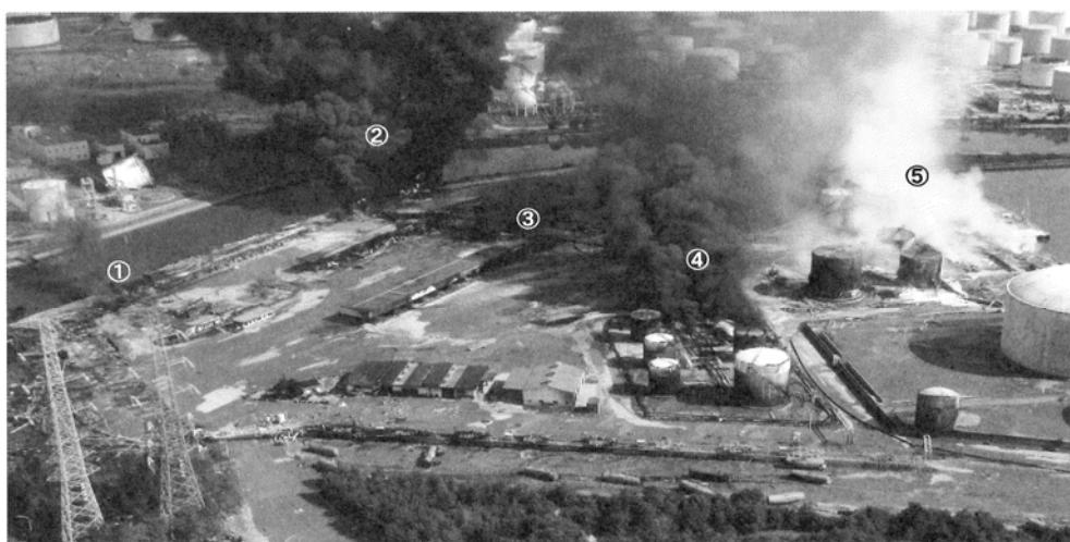
図 1 コンビナート火災の延焼状況 (管轄消防本部提供)
