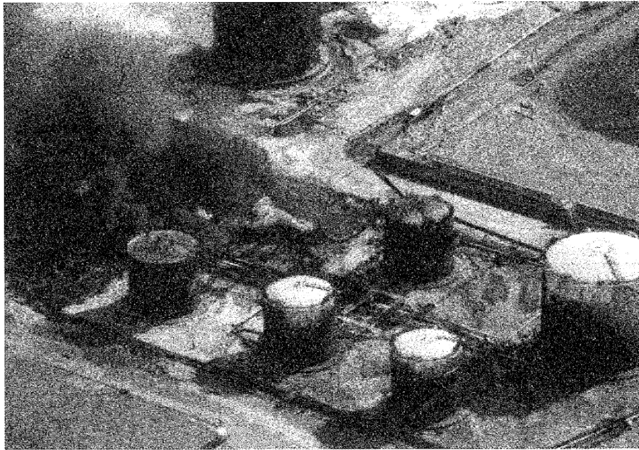
図4 火災時のガソリントankの状況
