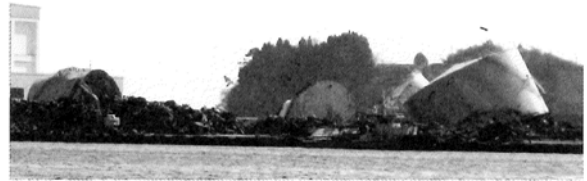
図2 南気仙沼地区のオイルタンク
