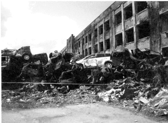
図4 延焼した小学校と自家用車の残骸
