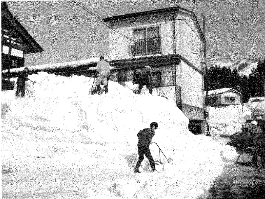
地域の協力による除雪作業 (提供：新潟県魚沼市)
