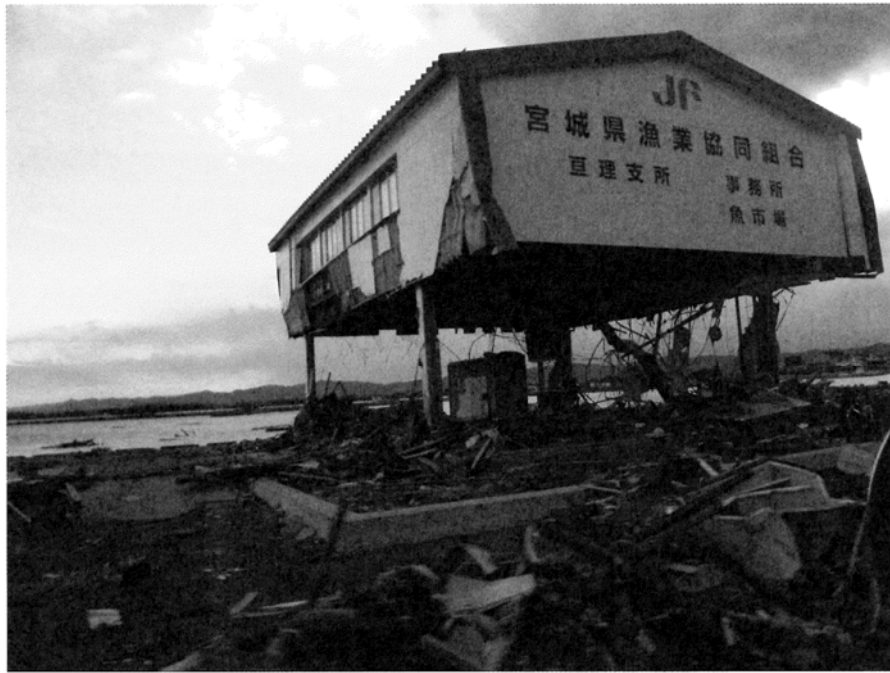
宮城県漁業協同組合巨理支所の被害状況
