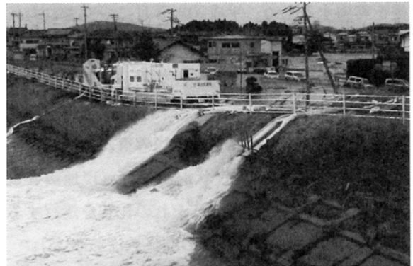
排水ポンプ車による排水状況
