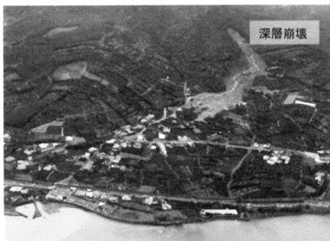
写真-1 針原川 (鹿児島県出水市)
